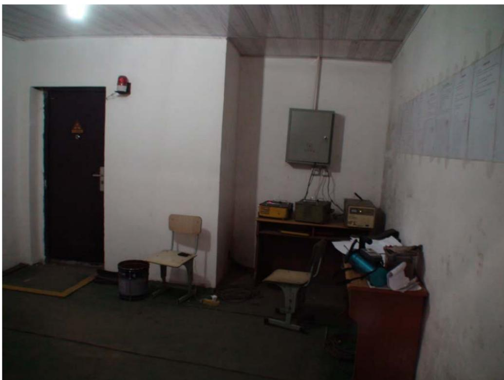
图 6-2 控制操作室警示灯、警戒线、电离辐射标志、制度上墙
